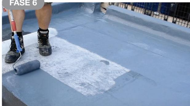
Applicazione di una seconda mano di membrana liquida **STARFLEX**.
