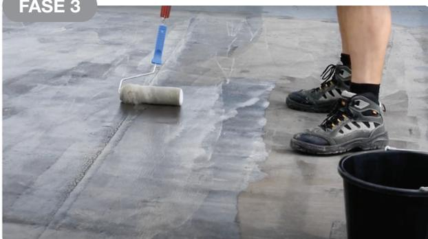
Applicazione di **primer specifico** per il piano di posa esistente.
