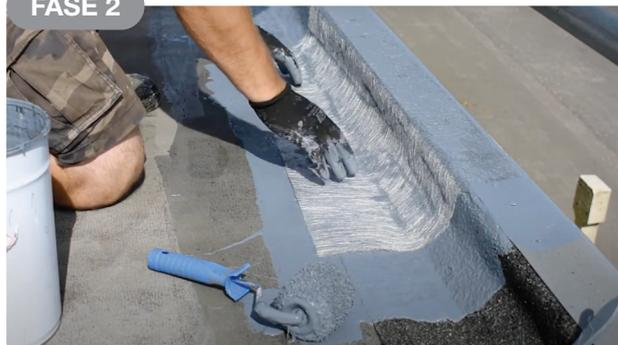
Armatura del perimetro e dei dettagli costruttivi con membrana liquida **STARFLEX** e tessuto **STARTEX NW DETAILS**.
