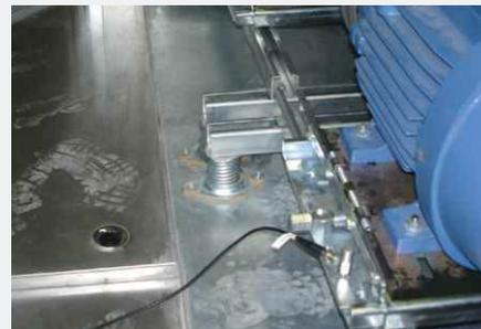
Isolation d'un appareil de climatisation avec Isotop SD et Isotop FP/K
