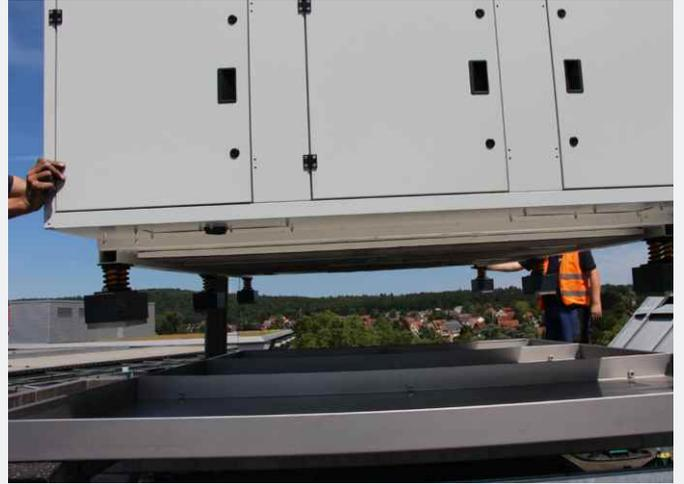
Installation de l'appareil avec Isotop DT prémonté
