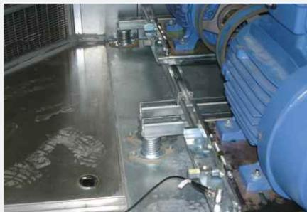
Isolation de ventilateurs à entraînement par courroie
