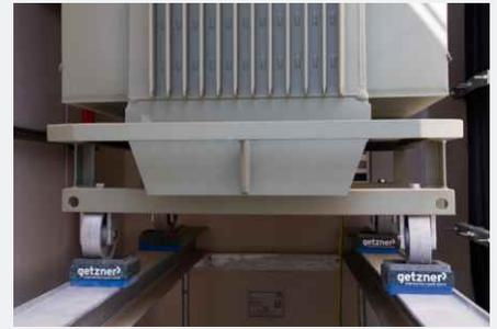
Isolation des vibrations générées par un transformateur
