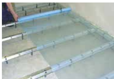
Installation flottante de 22 mm d'aggloméré
