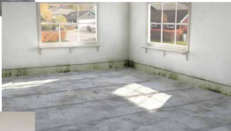
2. Nettoyage du dallage en béton, avec retrait de tout le matériau organique.
