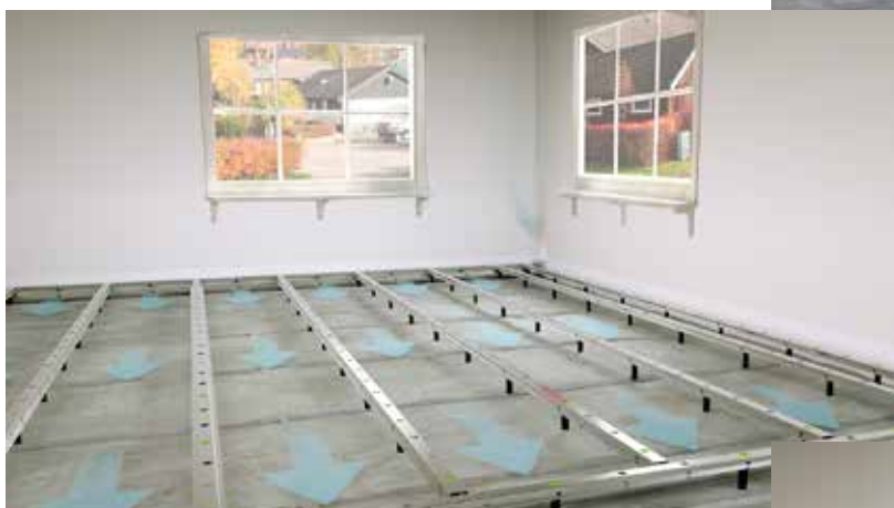
3. Installation du système de plancher technique Granab avec ventilation et isolation sous plancher.
