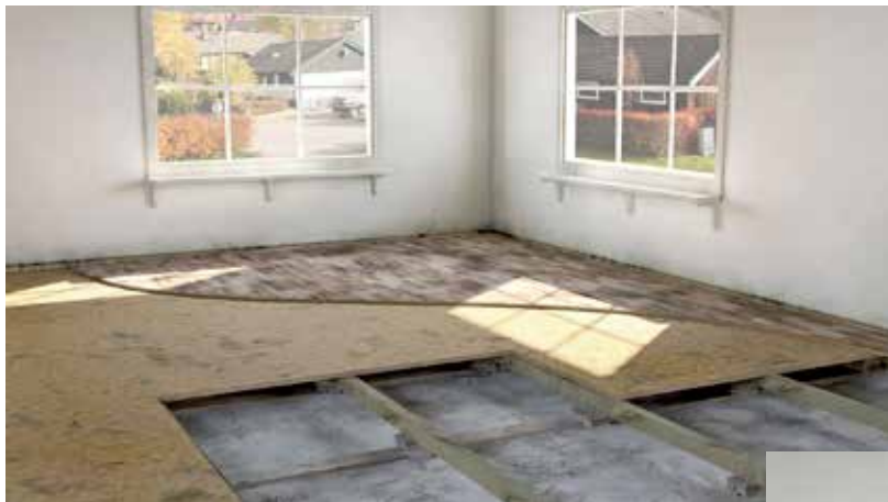
2. Nettoyage du dallage en béton, avec retrait de tout le matériau organique.
